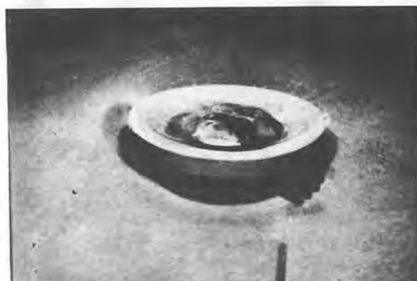
Fig. 10. - Il calice III ( R = 15 cm) in fase di funzionamento rigurgitato ( Q \leq 27,5 l/s).
