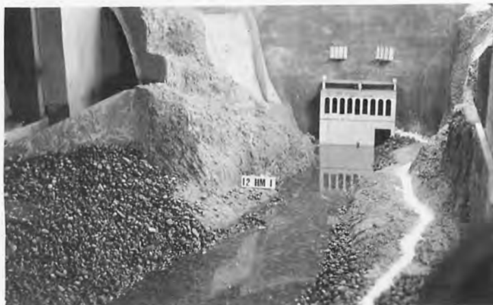
A. Right Spillway
