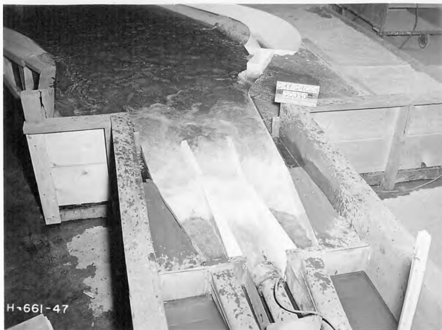
A. All conduits discharging - 9,400 second-feet
