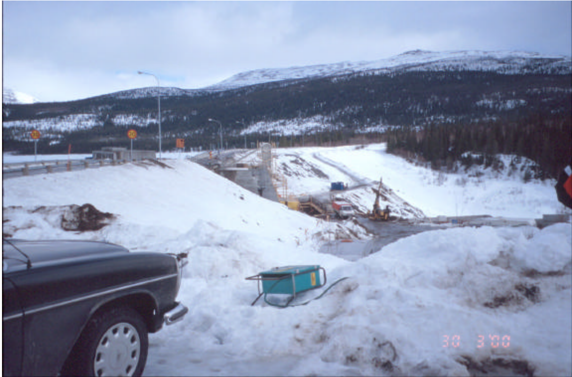
Ajaure Dam River Ume Alv (Vattenfall)
