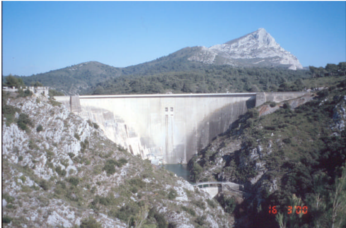
Bimont Dam Aix-en-Provence (Societe du Canal de Provence et d'amenagement de la region provencale (SCP))
