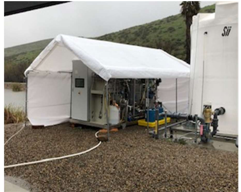
Padre Dam AWT
