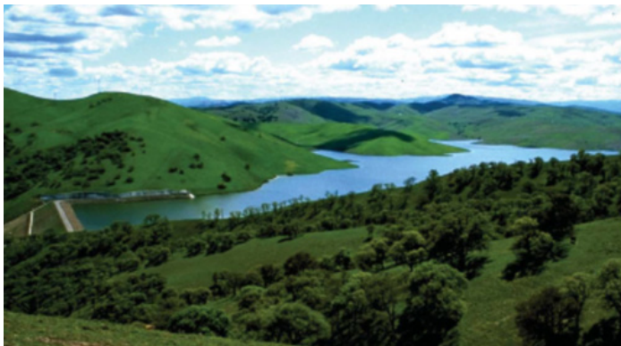
Aerial of Los Vaqueros Reservoir
