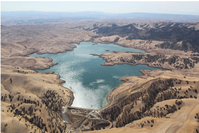
Aerial of Los Vaqueros Reservoir
