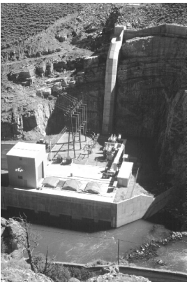
Buffalo Bill motopropulseur dans le canyon en aval du barrage.
