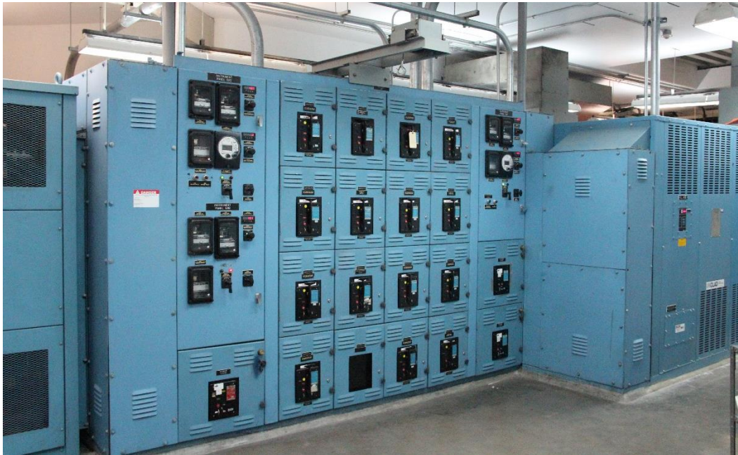
Figure 37. 480 volt switchgear.
